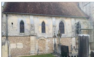
Les travaux de drainage périphérique, utiles à la réduction des remontées d'humidité dans les murs seront terminés pour la fin de l'année.
